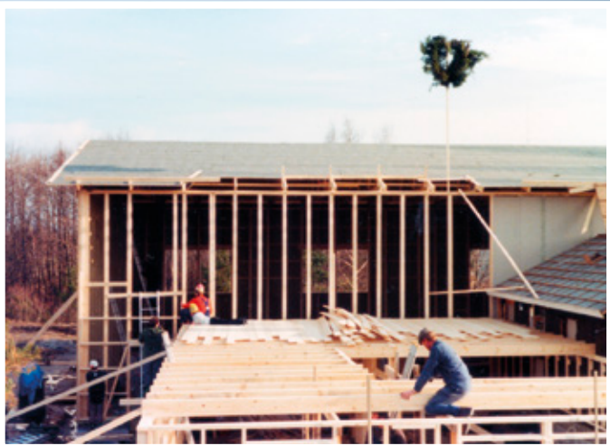
Samlade ideella krafter byggde KSK-huset 1981. Foto: Arne Tomasson
